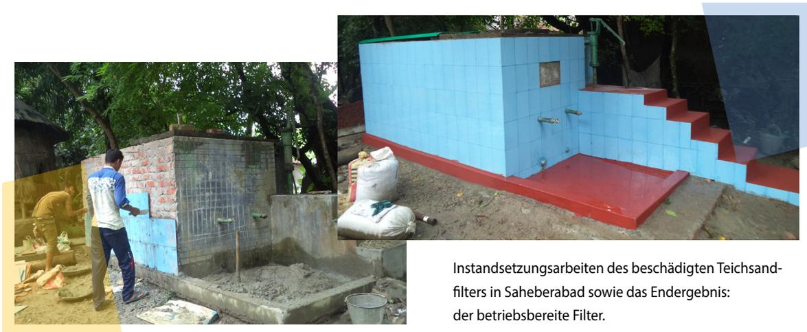
Instandsetzungsarbeiten des beschädigten Teichsandfilters in Saheberabad sowie das Endergebnis: der betriebsbereite Filter.
