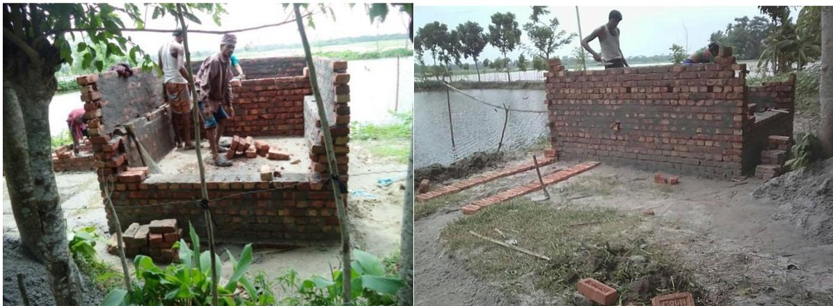
Abbildung 7 Neuer Sandfilter in West Bajua während der Bauphase
