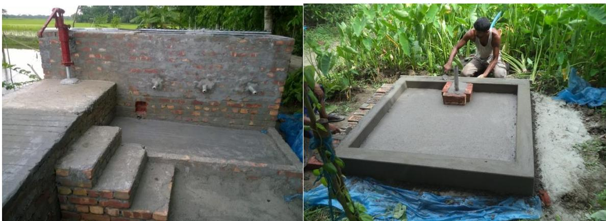
Abbildung 8 Neuer Sandfilter in West Bajua während der Bauphase, Trinkwasserentnahmestelle
