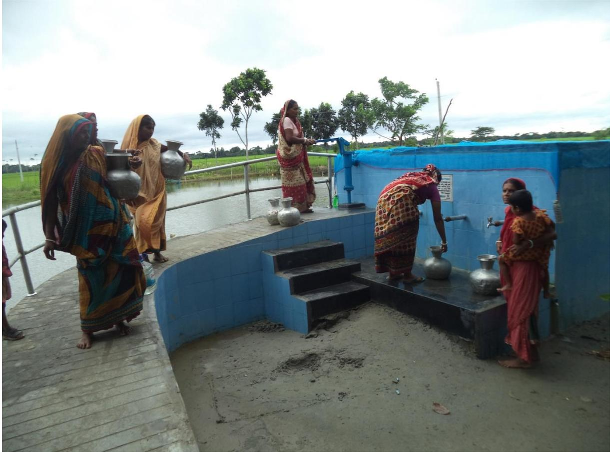
Abbildung 9 Neuer Sandfilter in West Bajua nach Abschluss der Bauphase mit barrierefreiem Zugang
