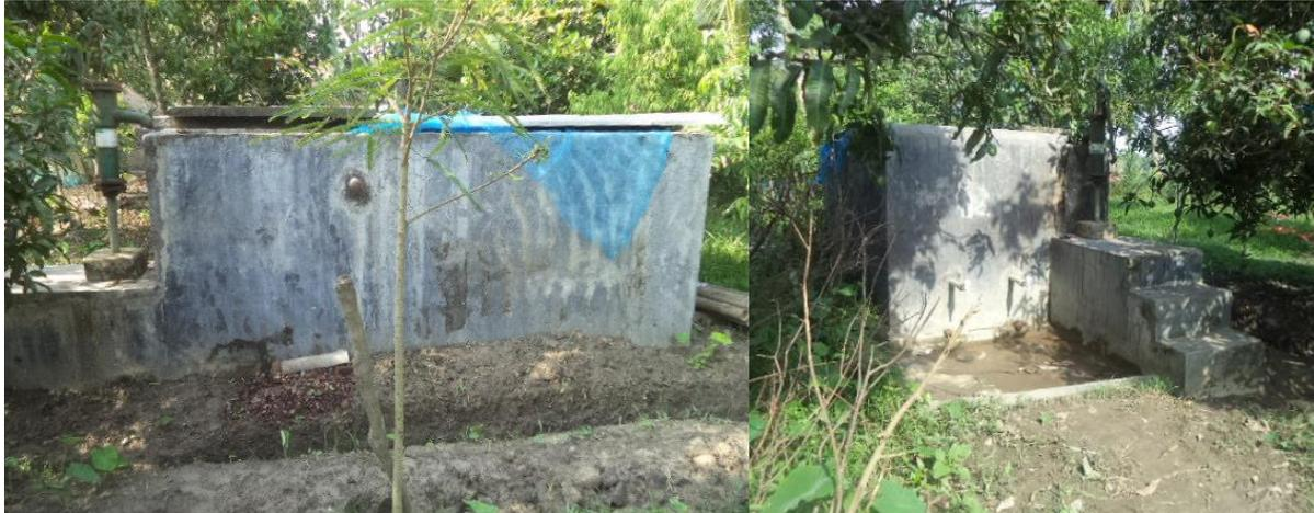
Abbildung 4 Beschädigter Sandfilter 2 im Dorf Podderganj vor Projektbeginn
