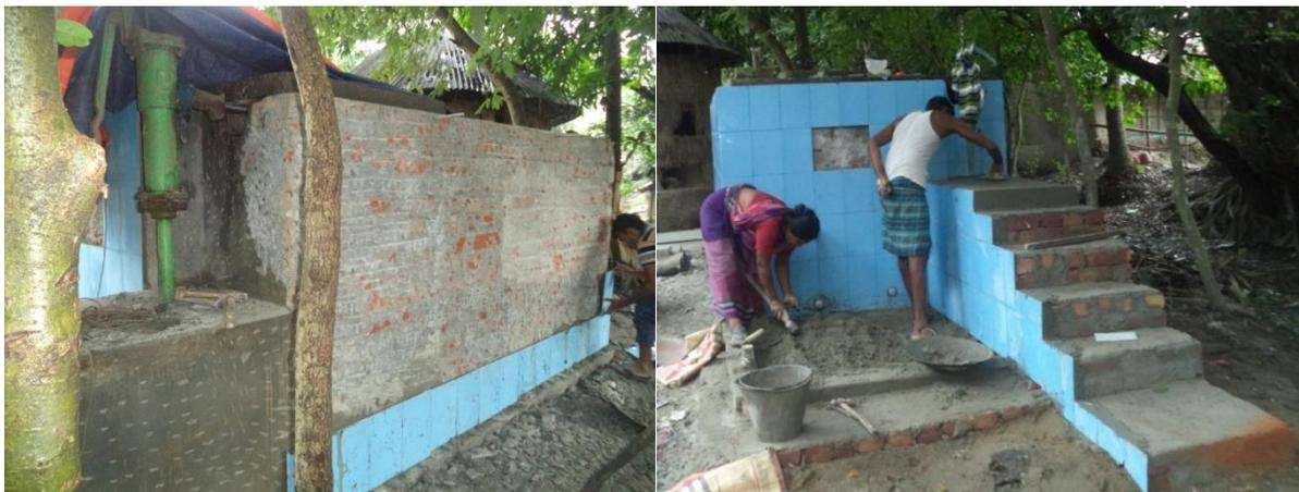
Abbildung 2 Sandfilter 1 in East Saheberabad während der Bauphase
